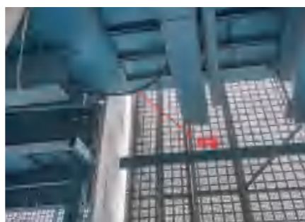
爬架交界处软管连接
