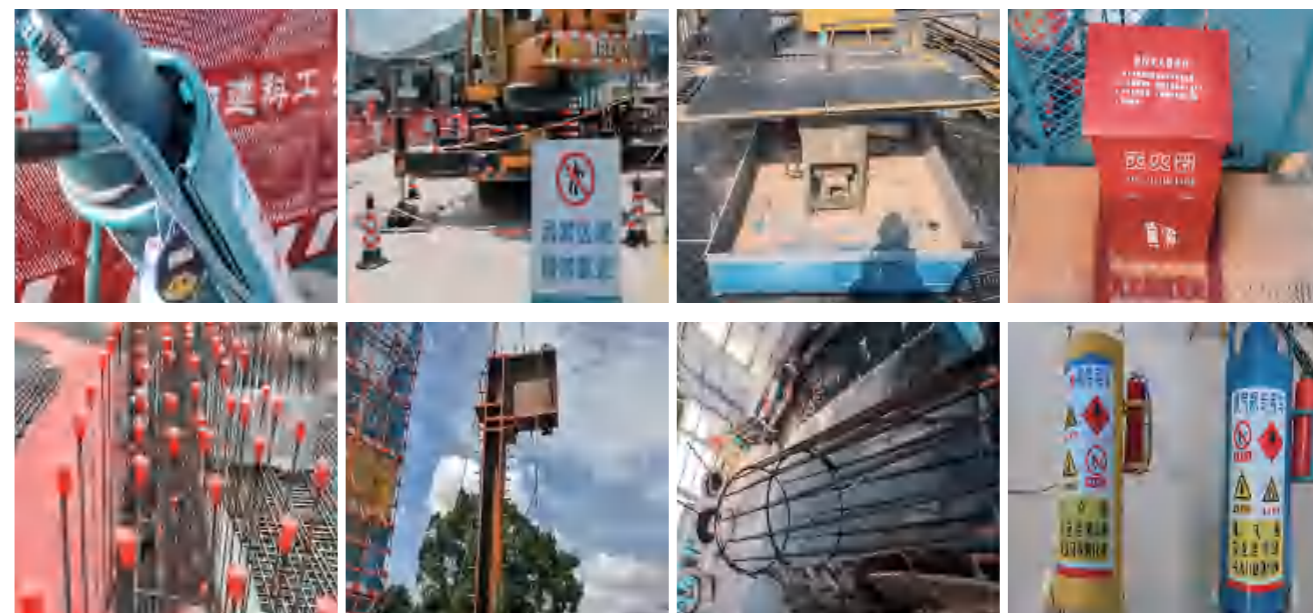
现场精细化实施
