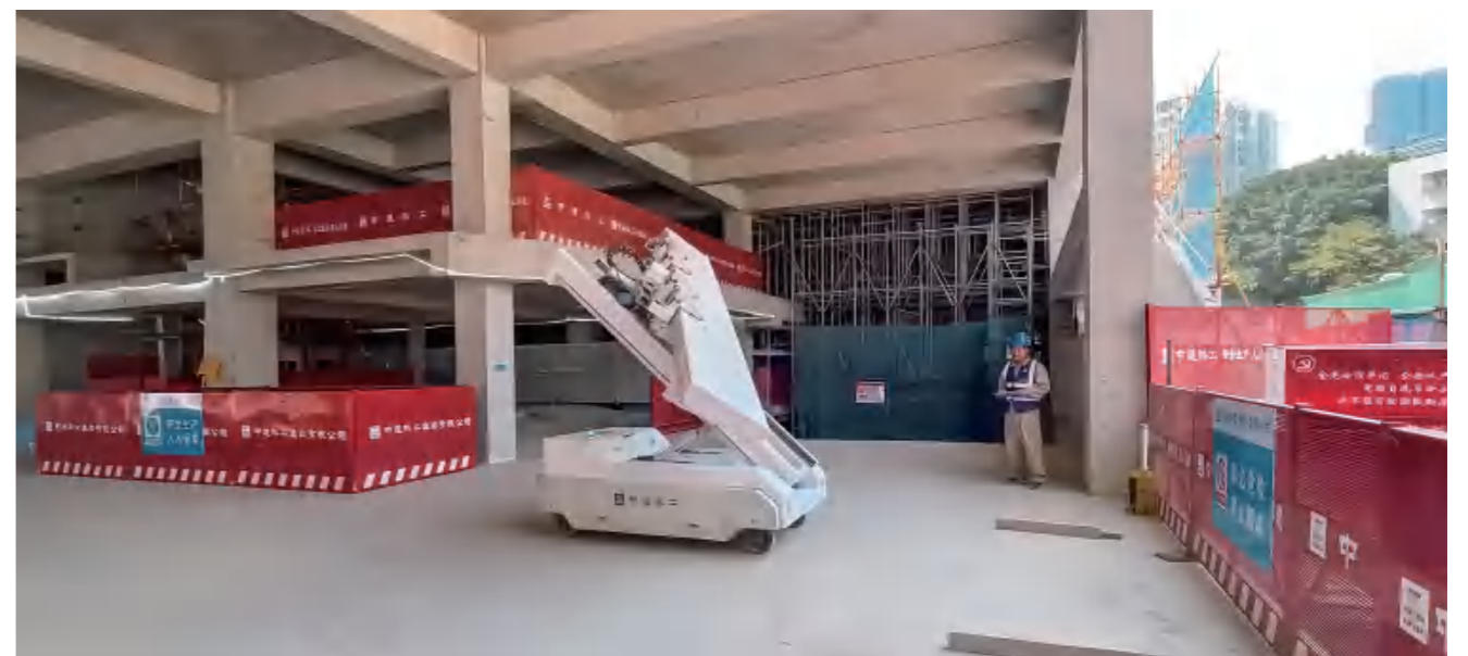
中建科工自主研发机墙板机器人
