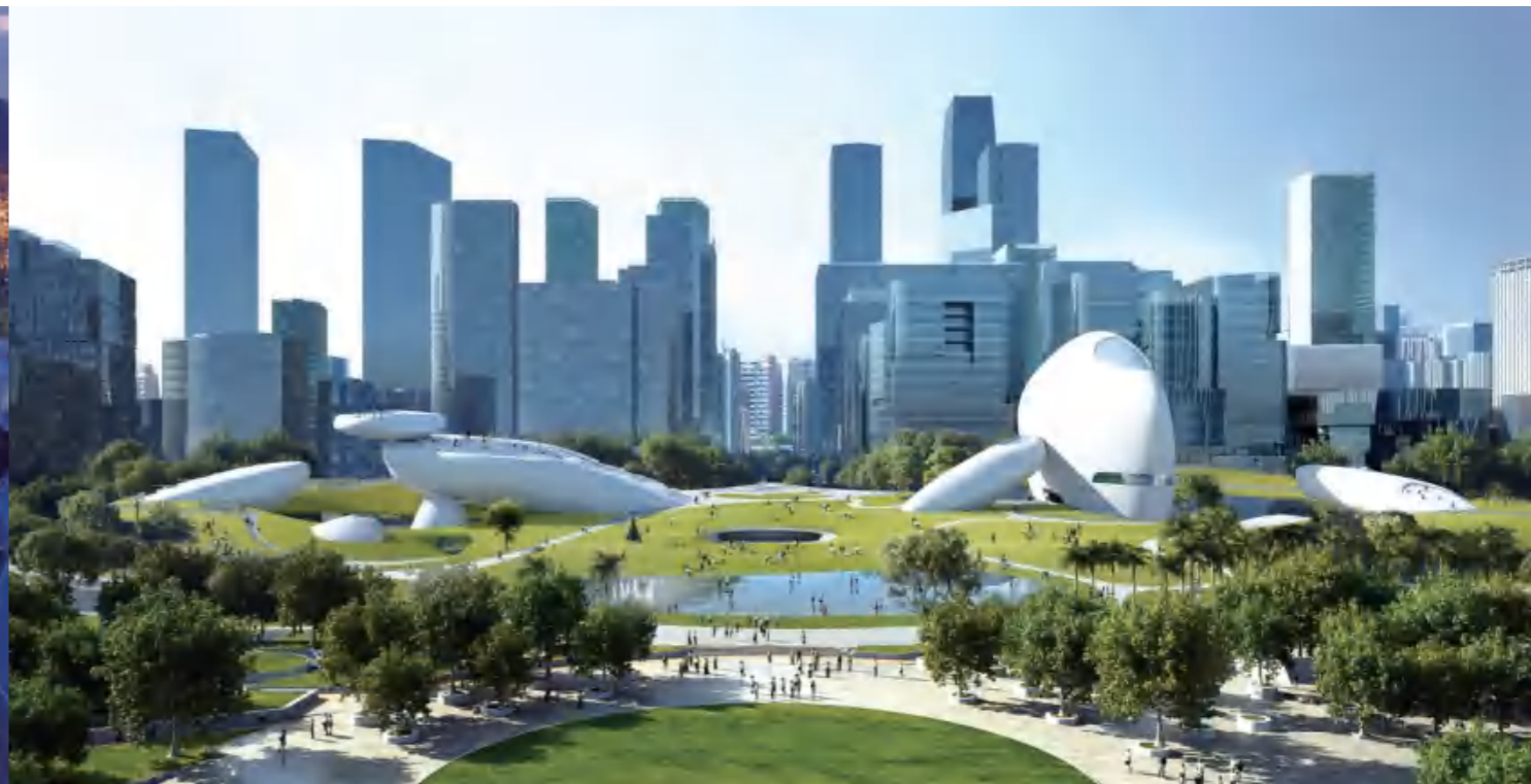
工勘集团承建深圳湾文化广场土石方、基坑支护及桩基础工程
