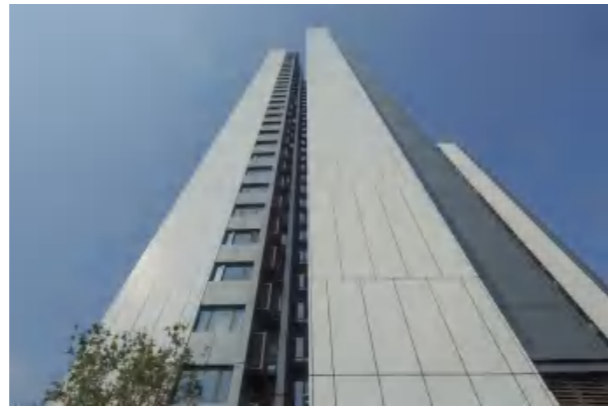
外墙铝板幕墙表面平整，分缝整齐，打胶饱满光滑
