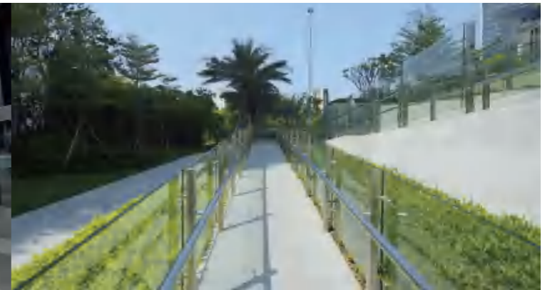
室外无障碍坡道不锈钢玻璃栏杆安装稳固，整齐美观
