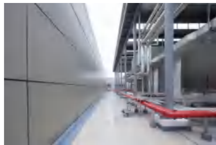
屋面坡度正确、设备安装整齐
