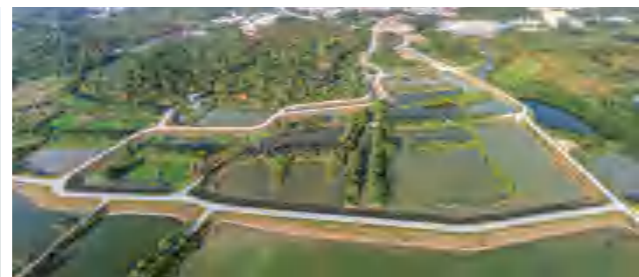
大鵬河流域水环境综合治理工程
