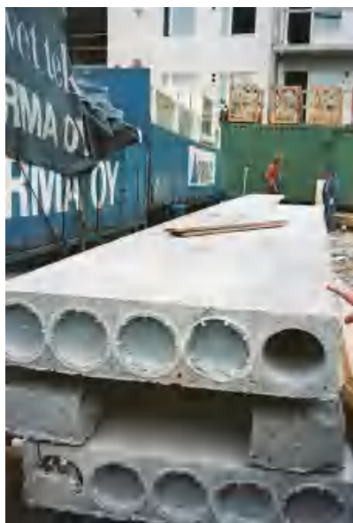
欧洲建筑工地的预制混凝土楼板
