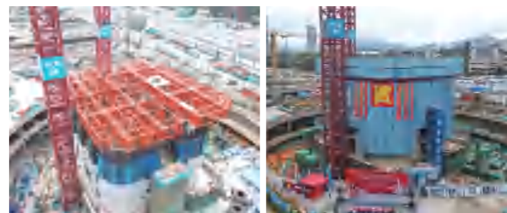
钢平台系统安装
