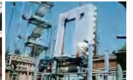
集合住宅入户门位置的预制混凝土墙体
